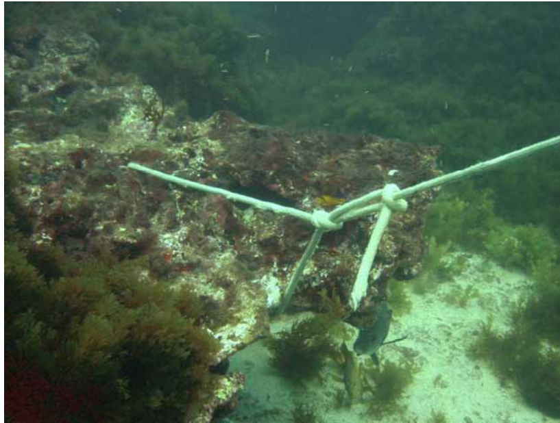
Figura 2.8. Poita de amarração localizada na Ilha do Meio, amarrada a rocha enquanto que o procedimento correto seria instalar a base sob o fundo arenoso.
