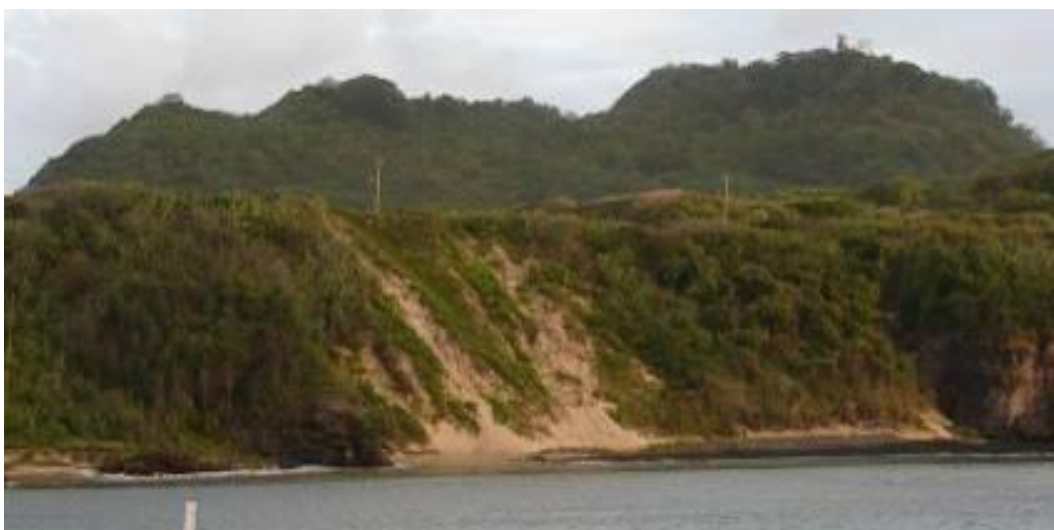
Figura 3.10 - Falésia de Santo Antônio acometida por erosão.
